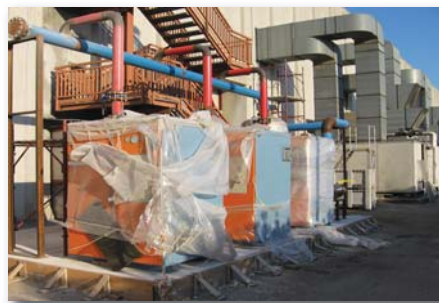
Le pompe per vuoto on site.
