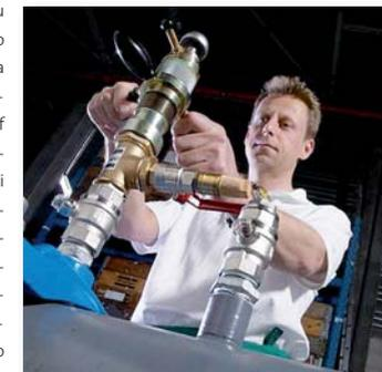
Installazione di flow meter AirScan.
