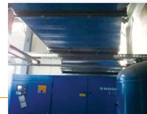
Uno dei compressori Boge da 150 cv con recupero di calore.
