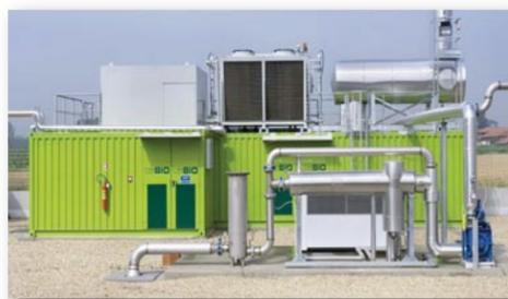
Fig. 1 - Sistema di trattamento e deumidificazione Biogas composto da filtro, Hypercool BioEnergy, Hypersep BioEnergy e Hyperchill BioEnergy.
