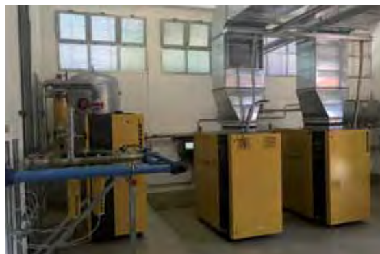
Sala compressori con recupero del calore dell'aria di raffreddamento delle macchine.
