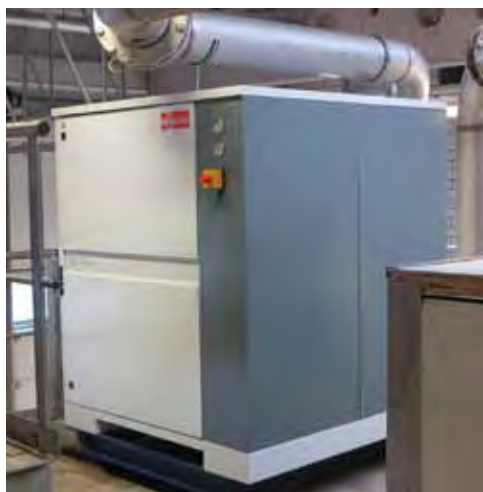
Il soffiatore rotativo a lobi Tyr di Busch è installato direttamente sopra i container dei materiali di scarto.
