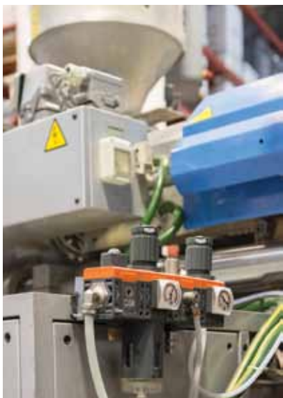
Gruppo di trattamento aria Syntesi montato su una pressa.
